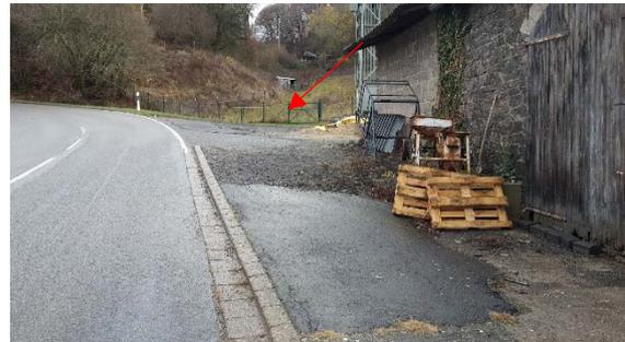
*Bild 25: Wollscheid 14, Abfluss aus Seitental ableiten*
