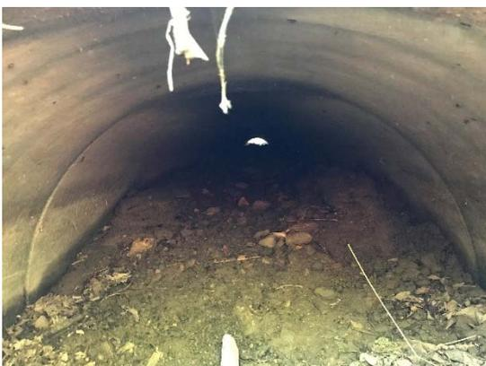
*Bild 29: GWG Kempenich 2, Rohr teilw. zugelegt*
