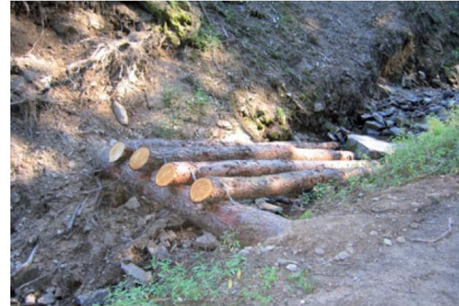
Rechen zum Treibgutrückhalt
