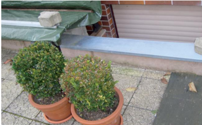
Mauer vor Kellerfenster
