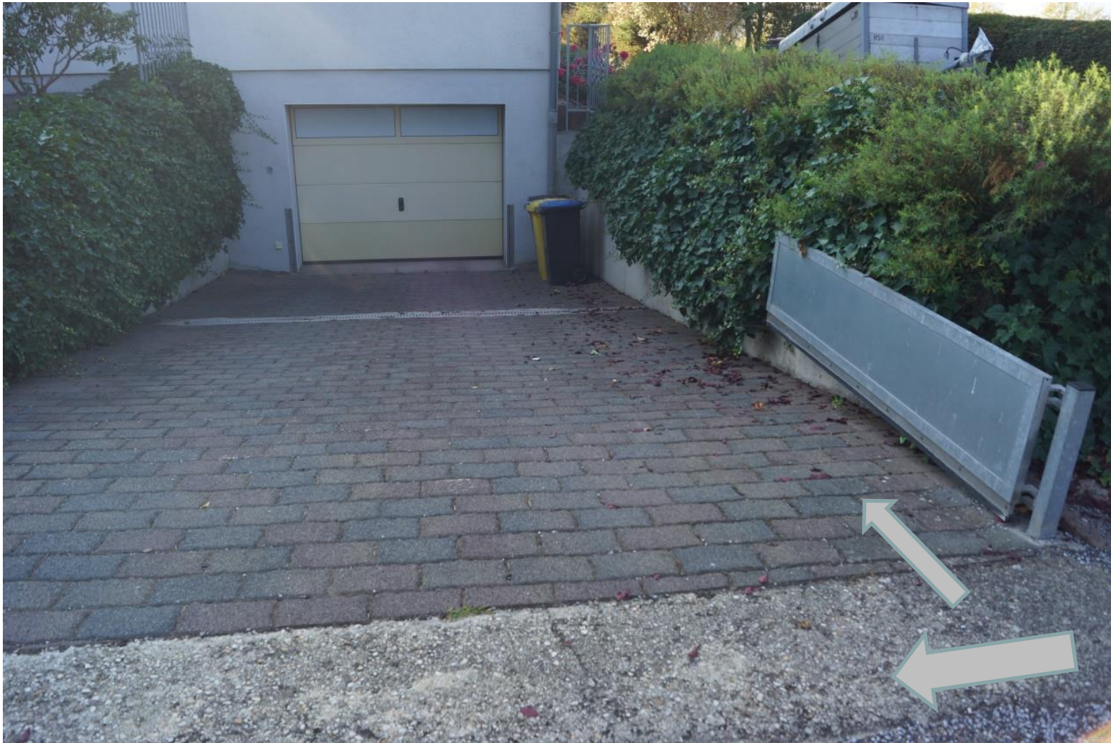
Mobiler Schutz einer tieferliegenden Garagenzufahrt
